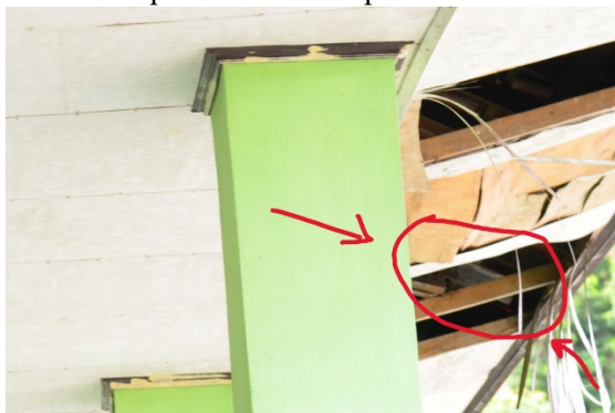
Gambar 12. Rangka atap berkarat
